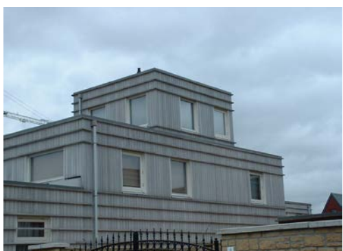
Afbeelding 5 Ongunstig: lichte beitskleuren versralen sneller en hebben een korter onderhoudsinterval.
