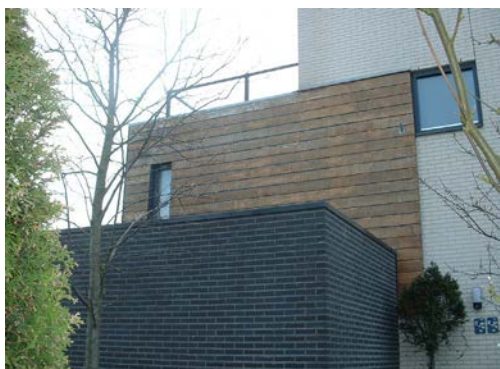
Afbeelding 3 Ongunstig: transparante afwerking.
