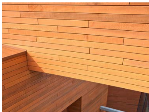
Afbeelding 4 Gunstig: 3 lagen kleurbeits op fijnbezaagd oppervlak.
