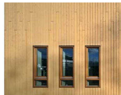
Afbeelding 2 Gevelbekleding in “wildverband”.
