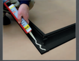
▶ STAP 4: Lijm aanbrengen op architraaf
