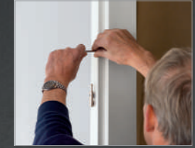
▶ STAP 1: Oude stalen montagekozijn verwijderen
