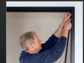
▶ STAP 7: Sponningrubber terugplaatsen
