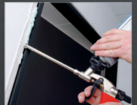
▶ STAP 6: Purschuim aanbrengen + architraaf bevestigen
